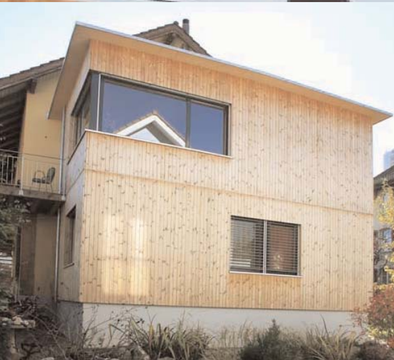
Anbau mit Atelier zu Zweigenerationenhaus Architekt: AAP - Atelier für Architektur und Planung, Bern
