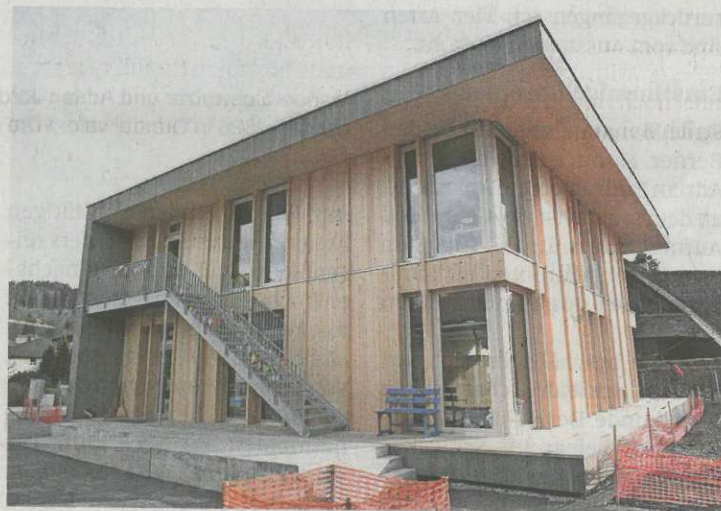
Die Holzmodule aufzubauen, dauert weniger als zwei Wochen.
