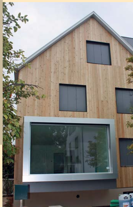
Abbruch Dachgeschoss und Aufstockung, Minergie zertifiziert (heimische Lärche) Von HERZOG ausgeführt: Zimmerarbeiten, Baumeisterarbeiten Architekt: W2H Architekten AG, Bern
