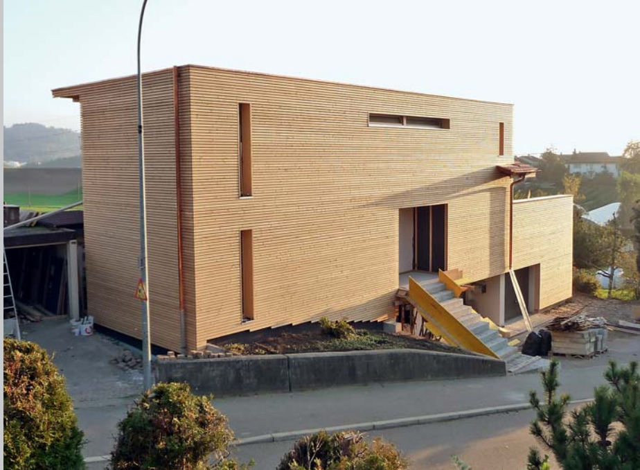
Wohnraumerweiterung und Aufstockung (nordische Fichte) Von HERZOG ausgeführt: Zimmerarbeiten Architekt: m+b Architekten, Bern
