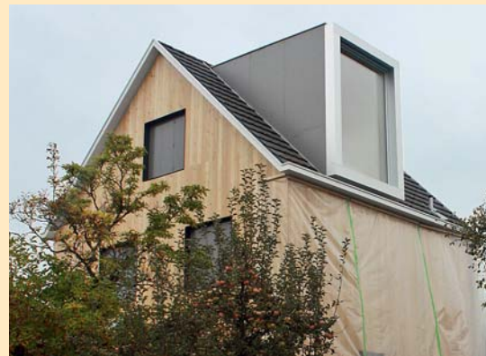
Abbruch Dachgeschoss und Aufstockung, Minergie zertifiziert (heimische Lärche) Von HERZOG ausgeführt: Zimmerarbeiten, Baumeisterarbeiten Architekt: W2H Architekten AG, Bern
