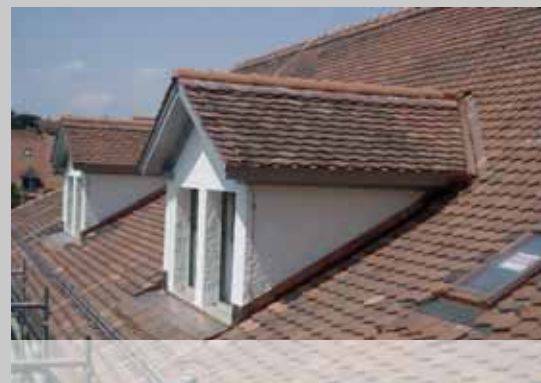
Bei Dachaufbauten wie diesen Lukarnen mit Satteldach muss der Konstrukteur Ästhetik und Funktionalität gleichermassen beachten.
