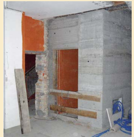
Im Eingangsbereich wurde ein Lift eingebaut. Aus statischen Gründen musste der Liftschacht im Unter- und Erdgeschoss betoniert statt gemauert werden.
