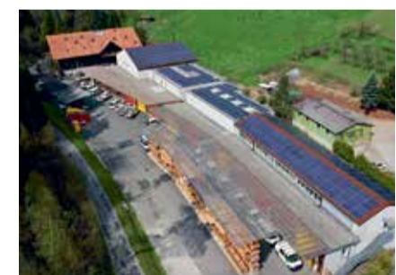
Der Werkhof in Stettlen mit Photovoltaikanlage als Stromquelle für den Eigenbedarf
