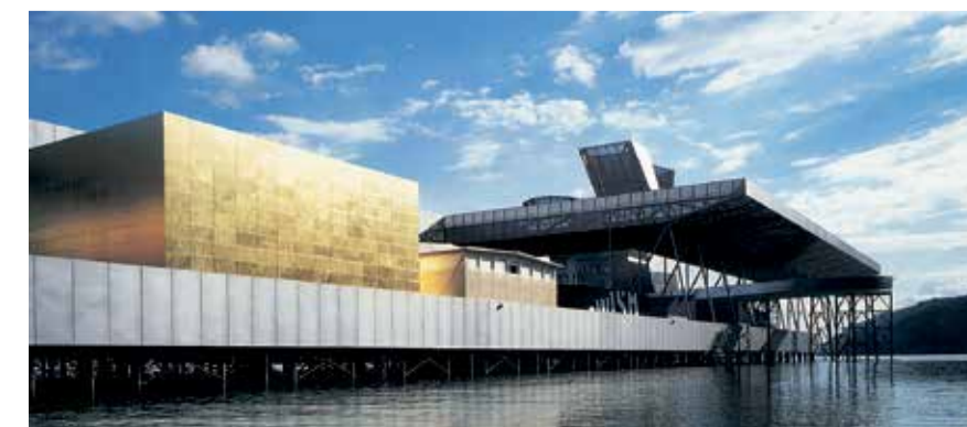
Pavillon der Nationalbank an der Expo.02 auf der Artepilgplatz
